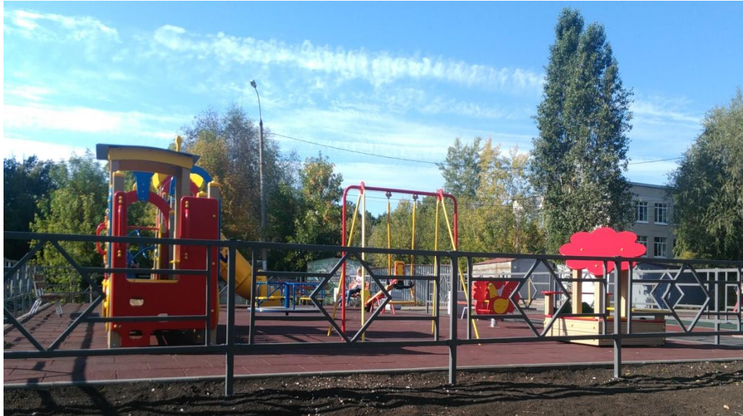
установка ограждения вокруг детской площадки
