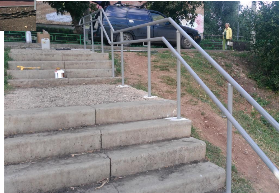
установка поручней на лестнице
